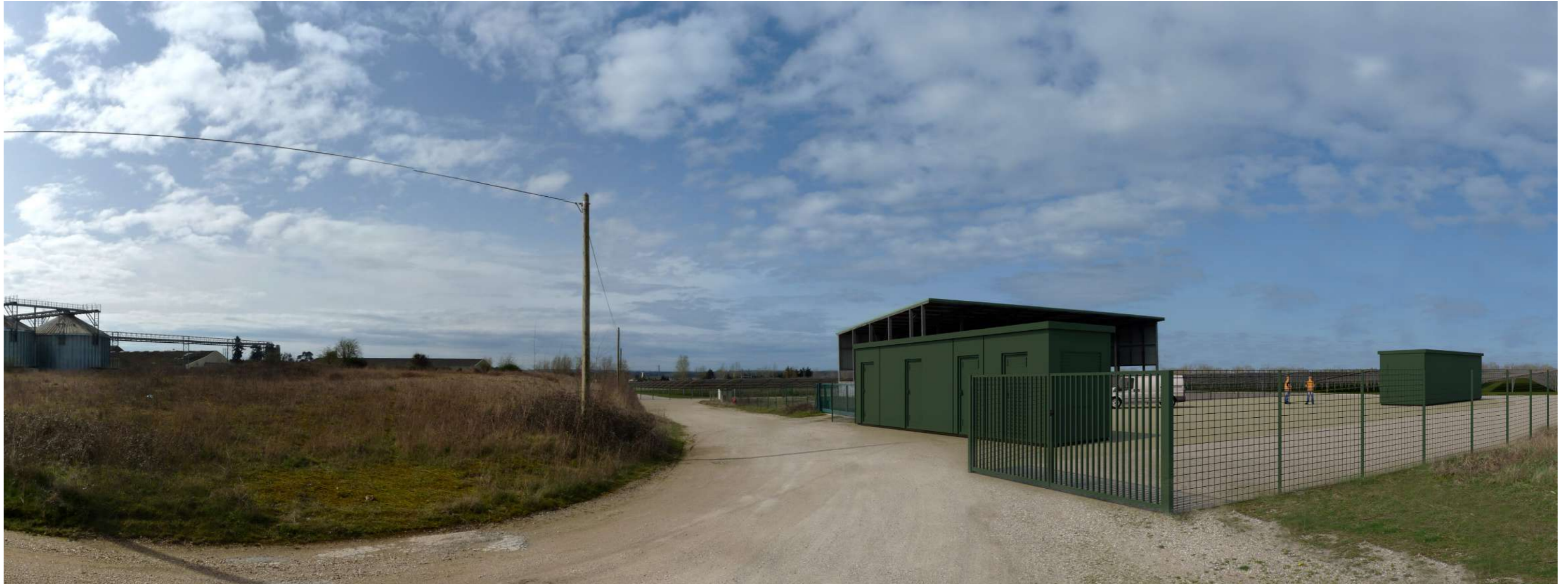
PV2- depuis l'entrée du projet
